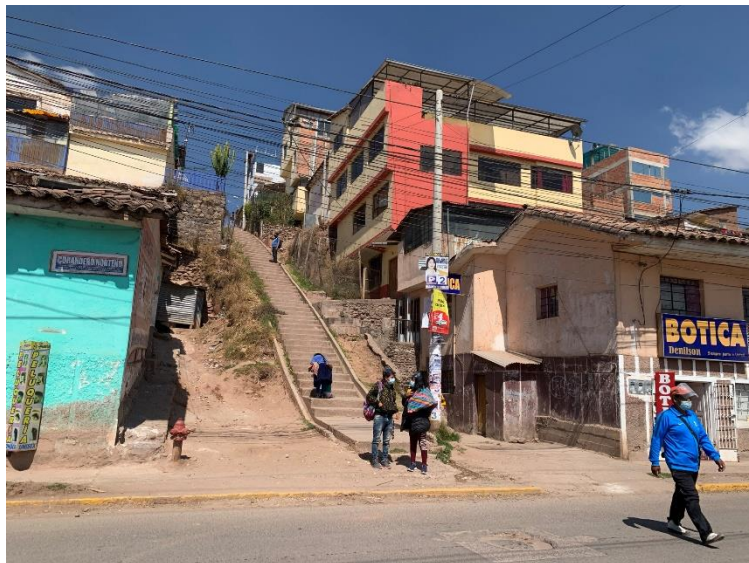
Imagen N° 18: Fotografía “Pasaje S/N 01” en estado de conservación regular
