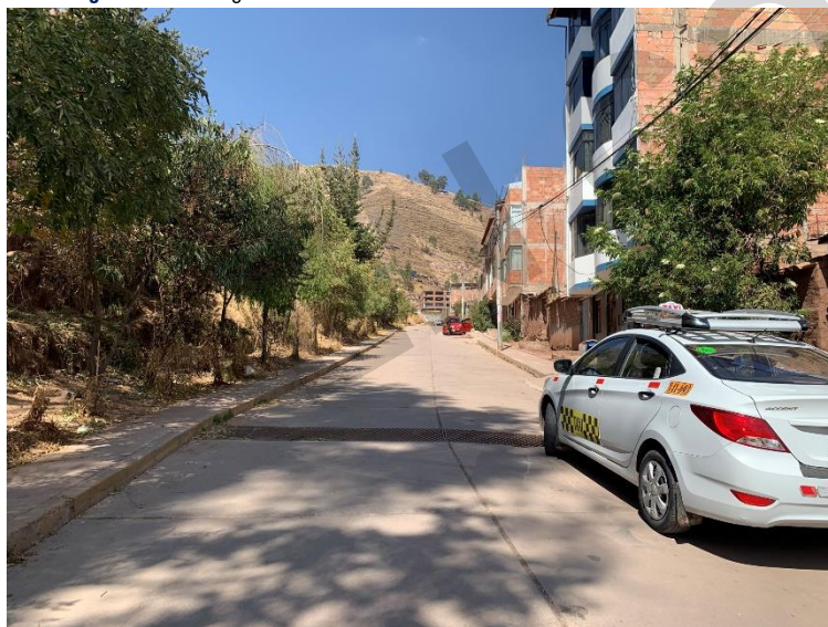
Imagen N° 19: Fotografía “Calle Villa las Flores” en estado de conservación bueno
