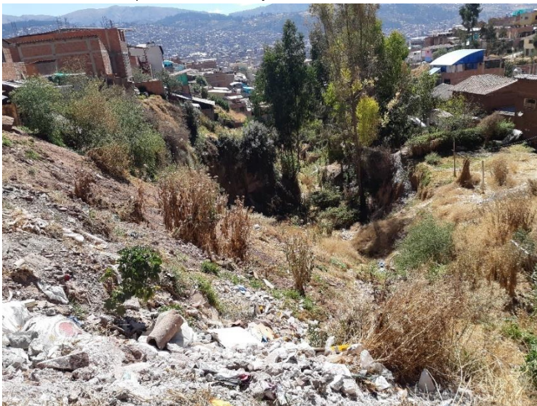
Imagen N° 68: Vista parcial de la quebrada Quinsa Huayco (parte baja). Se evidencia presencia de residuos y escombros
