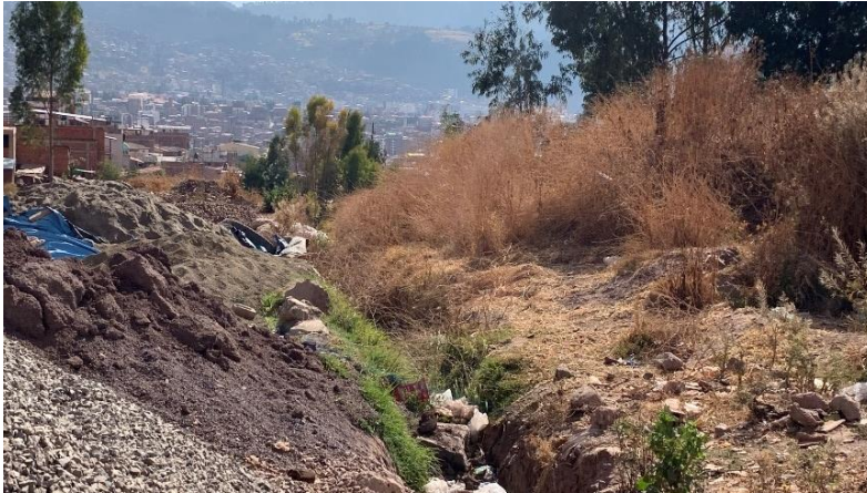
Imagen N° 57: Fotografía de relleno de la quebrada Quinsa Huayco con residuos de la construcción
